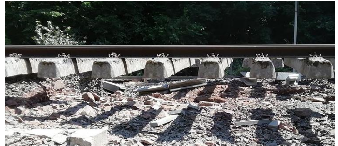
Oberbau zwischen Blankenheim und Nettersheim / DB AG
