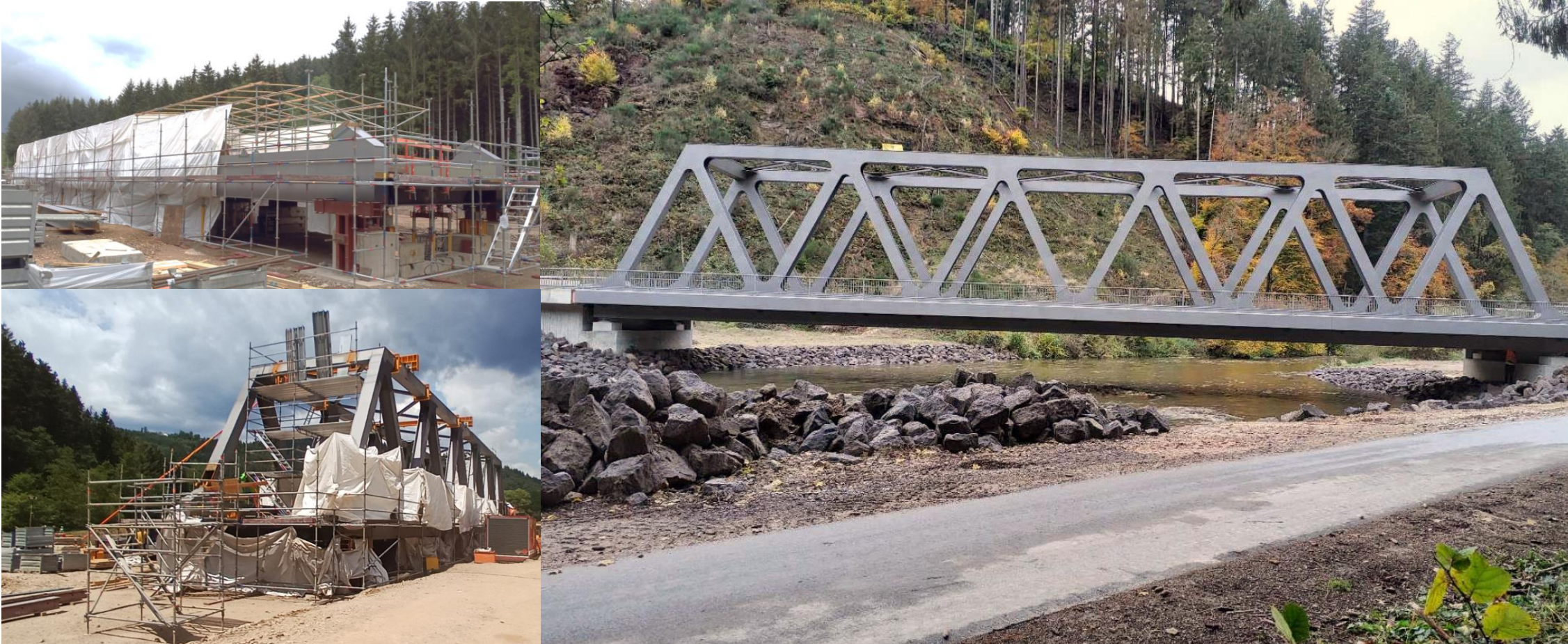
Neubau der Brücke "Herzwäldchen" in hochwasserresilienter Bauweise ohne Mittelpfeiler / DB AG
