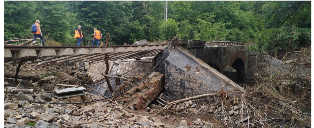
Brücke Urft im Juli 2021 im Bereich Kall-Sötenich / DB AG
