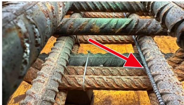
Abbildung 4: Installation von Sensoren an der EÜ Oder (links: Übersicht von Messstrecken, rechts: DFOS-Sensor im Bewehrungskorb)
