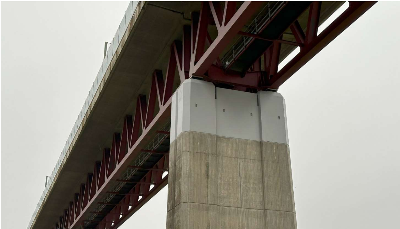
Abbildung 6: Pfeilerköpfe der EÜ Itztalbrücke nach der Beschichtung, wobei DFOS-Sensoren bereits in den Nuten eingeklebt wurden
