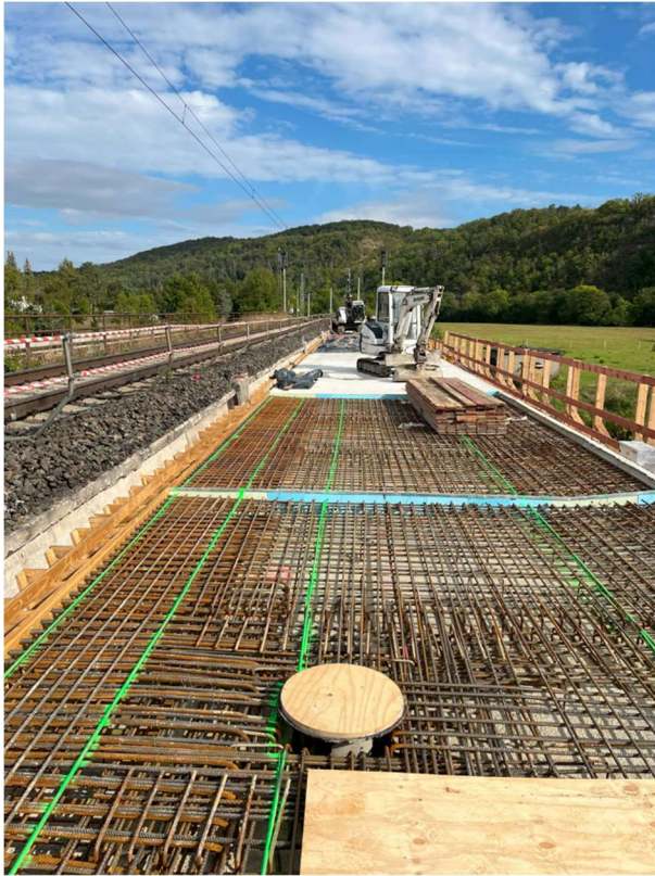
Abbildung 8: Installation von DFOS-Sensoren in der Platte (links: Übersicht, rechts: Detail der Sensorführung durch eine Querfuge)
