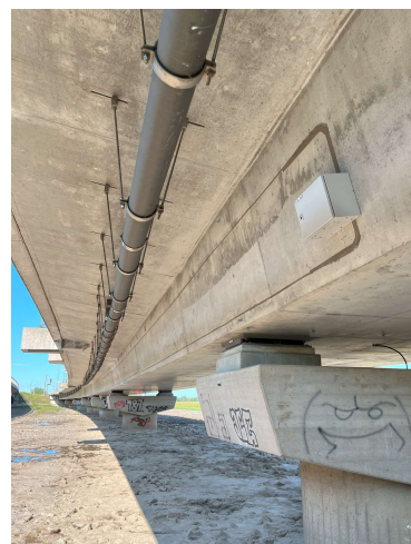
Abb. 8. Der Brückenbauwerk mit installierten DFOS-Sensoren
