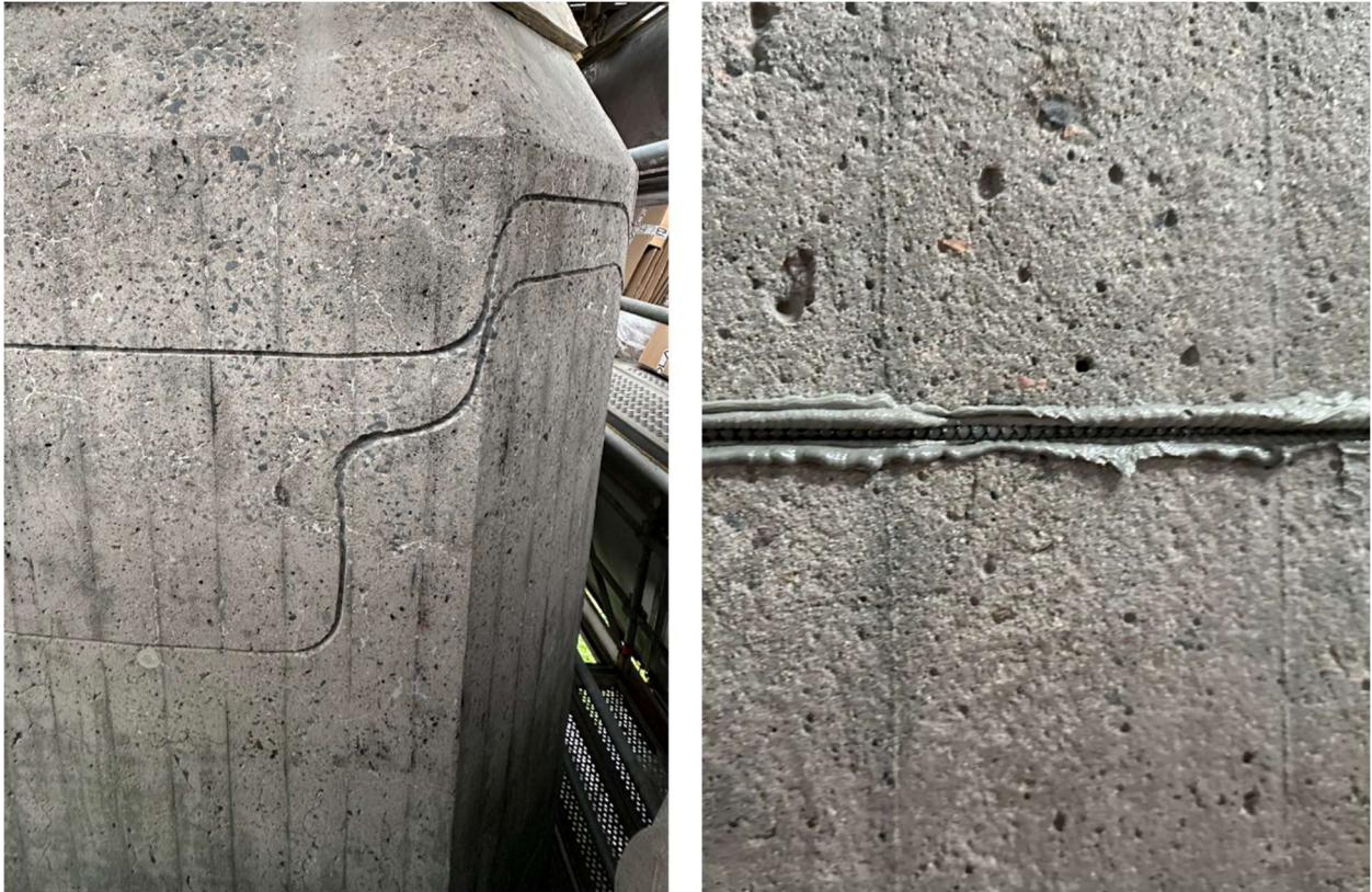
Abbildung 7: Installation von DFOS-Sensoren vor Aufbringung der Beschichtung
