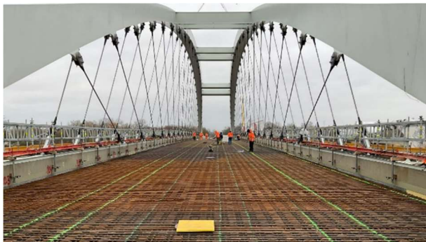
Abbildung 4: Installation von Sensoren an der EÜ Oder (links: Übersicht von Messstrecken, rechts: DFOS-Sensor im Bewehrungskorb)
