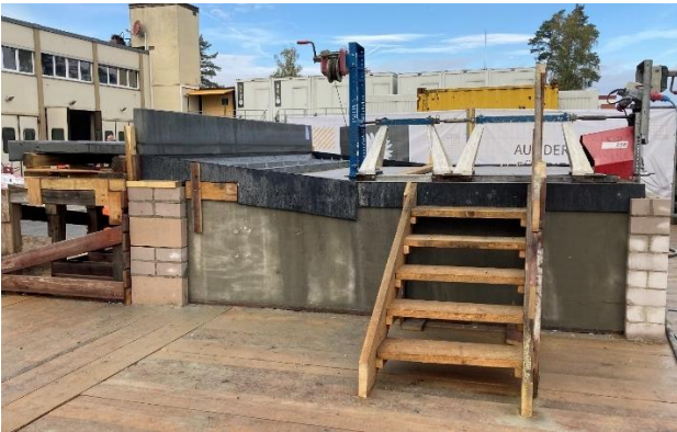
Abbildungen 25, 26, 27, 28: Aktueller Zustand der EÜ zw. TG-MLK (oben links) und Visualisierung nach der optisch zurückhaltenden Teilerneuerung mit eingefärbtem UHFBC (oben rechts) des denkmalgeschützten Bauwerks. Herstellung des UHFBC-Probeteils (unten links) und Testen des Einbaus, der Verarbeitbarkeit und Nachbehandlung von UHFBC, hier im 10 %-Gefälle (unten rechts) (Fotos: MKP GmbH, Okt. 2023; Visualisierung oben rechts: ICL Rail GmbH).
