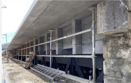
Abbildungen 6, 7, 8: Einbau der UHFB-Schottertrog-Fertigteile auf die genieteten Stahlbrücken (Fotos: E. Brühwiler 30.05., 03.07. und 07.08.2024).
