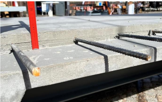
Abbildungen 32, 33, 34: oben links: Betonage im Fertigteilwerk, der spätere Schottertrug ist dabei senkrecht aufgestellt. Oben rechts und unten links: Detail der Anschlussfuge, die mit UHFV vergossen wird. Unten rechts: Ausstellung des Musterbauteils bei den Chemnitzer Eisenbahntagen 2024 (Fotos: oben links: M. Großkopf, oben und unten rechts: M. Falk, unten links: C. Pelka, 2024).
