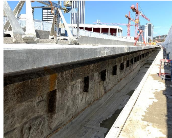
Abbildungen 9 und 10: links: mit UHFB ausgekleideter neuer (breiterer) Schottertrog auf dem Mauerwerksviadukt; rechts: auskragende UHFB-Platte über der originalen Mauerwerkskrone (Fotos: E. Brühwiler 15.08.2024).
