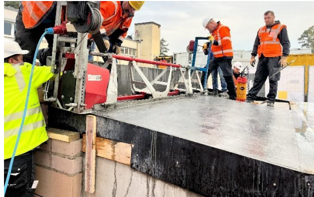
Abbildungen 25, 26, 27, 28: Aktueller Zustand der EÜ zw. TG-MLK (oben links) und Visualisierung nach der optisch zurückhaltenden Teilerneuerung mit eingefärbtem UHFBC (oben rechts) des denkmalgeschützten Bauwerks. Herstellung des UHFBC-Probeteils (unten links) und Testen des Einbaus, der Verarbeitbarkeit und Nachbehandlung von UHFBC, hier im 10 %-Gefälle (unten rechts) (Fotos: MKP GmbH, Okt. 2023; Visualisierung oben rechts: ICL Rail GmbH).
