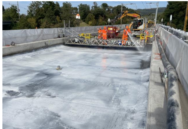
Abbildungen 21, 22, 23, 24: SU Landstrasse (oben links) und Viadukt Fislisbach (oben rechts) (Fotos: SBB). Einbau des Frisch-UHFB (unten links) auf dem Betonschottertrog des Viadukts Fislisbach und umgebende Applikation einer Wachsschicht als Nachbehandlung (unten rechts) (Fotos: KIBAG Sommer 2023).
