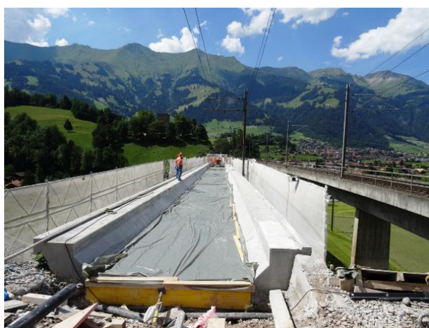
Abbildungen 17, 18, 19, 20: Eingerüstetes Mauerwerksviadukt (oben links). UHFB-Auskleidung des Betontrogs: UHFB-Einbau auf seitlicher Aufbordnung (geschalt) und Dienststeg (oben rechts); auf dem Tragbo den (unten links) und Gesamtansicht nach Abschluss des Einbaus (unten rechts) (Fotos: E. Brühwiler 05.07.2017).
