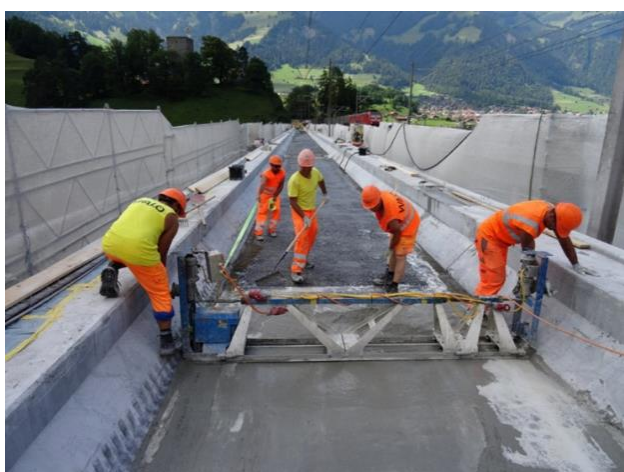
Abbildungen 17, 18, 19, 20: Eingerüstetes Mauerwerksviadukt (oben links). UHFB-Auskleidung des Betontrogs: UHFB-Einbau auf seitlicher Aufbordnung (geschalt) und Dienststeg (oben rechts); auf dem Tragbo den (unten links) und Gesamtansicht nach Abschluss des Einbaus (unten rechts) (Fotos: E. Brühwiler 05.07.2017).
