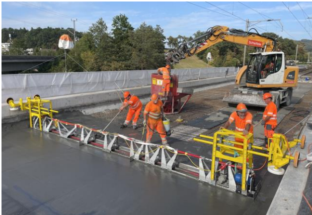
Abbildungen 21, 22, 23, 24: SU Landstrasse (oben links) und Viadukt Fislisbach (oben rechts) (Fotos: SBB). Einbau des Frisch-UHFB (unten links) auf dem Betonschottertrog des Viadukts Fislisbach und umgebende Applikation einer Wachsschicht als Nachbehandlung (unten rechts) (Fotos: KIBAG Sommer 2023).
