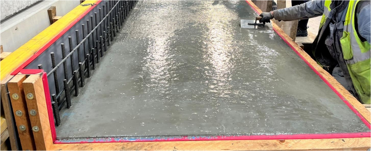
Abbildung 4: Abziehen einer frischen UHFB-Schicht mit Kelle, das Herausziehen von Kurzfasern wird durch den Auftrag einer Glätthilfe (blaue Flüssigkeit) verhindert (Foto: MKP GmbH Oktober 2023)
