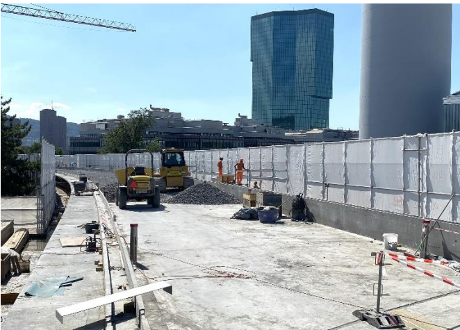
Abbildungen 9 und 10: links: mit UHFB ausgekleideter neuer (breiterer) Schottertrog auf dem Mauerwerksviadukt; rechts: auskragende UHFB-Platte über der originalen Mauerwerkskrone (Fotos: E. Brühwiler 15.08.2024).
