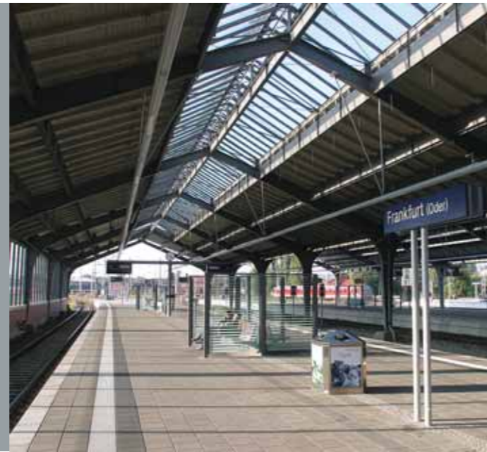
Wartebereich am Bahnsteig
